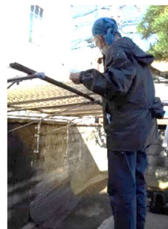
波板屋根の補修
