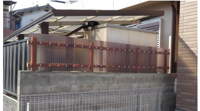
ブロック塀上に目隠しを製作設置
