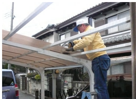
ガレージの波板の張り替え
