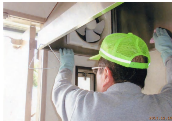
清掃した換気扇を取り付けて作業完了
